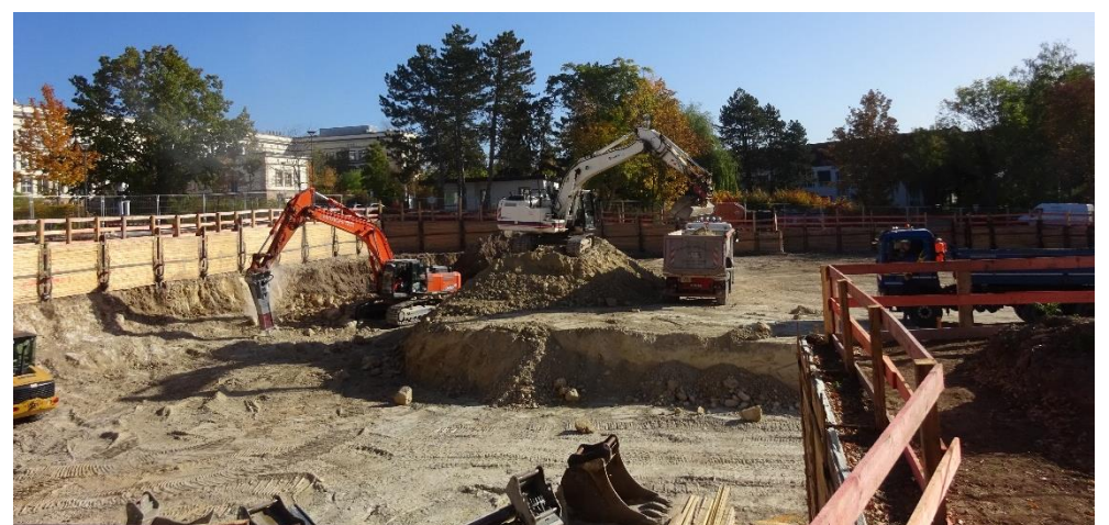
Trägerbohlverbau, in Teilen rückverankert und rückbaubar
