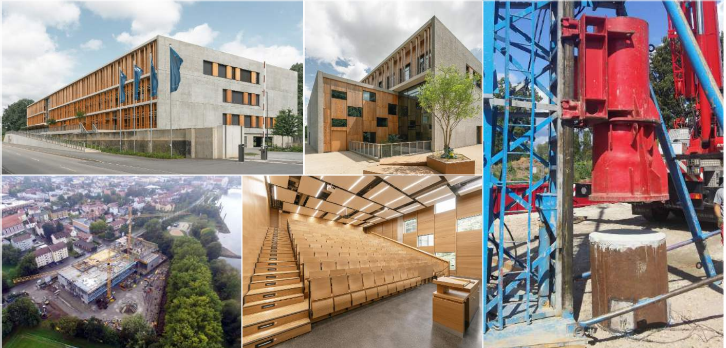
Fotos oben links und Mitte sowie unten Mitte: Felix Meyer Restliche Fotos: ISP-Scholz Beratende Ingenieure AG
