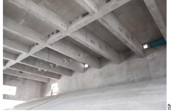
Abb. 8: Tragwerk Hörsaal, Vierendeelträger auf der Oberseite als Gebäudefassade
