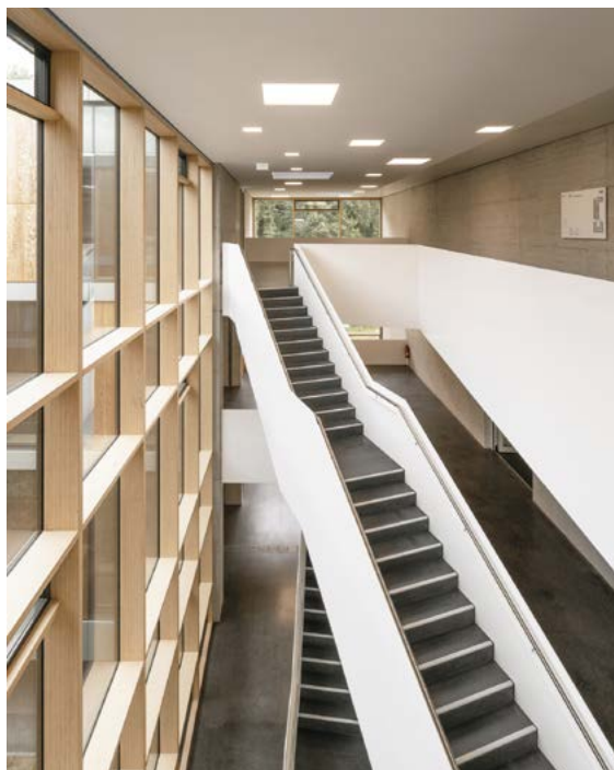
Abb. 13: Die Foyertreppe ist ein beeindruckendes dreidimensionales Faltwerk.
