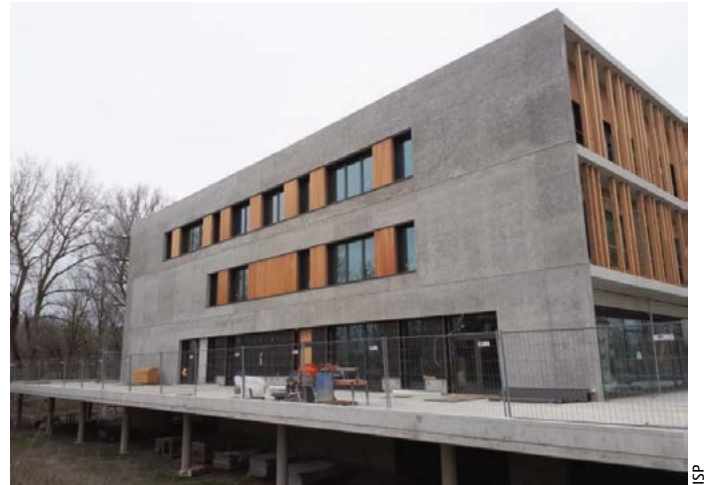
Abb. 11: die Fassade aus Infraleichtbeton
