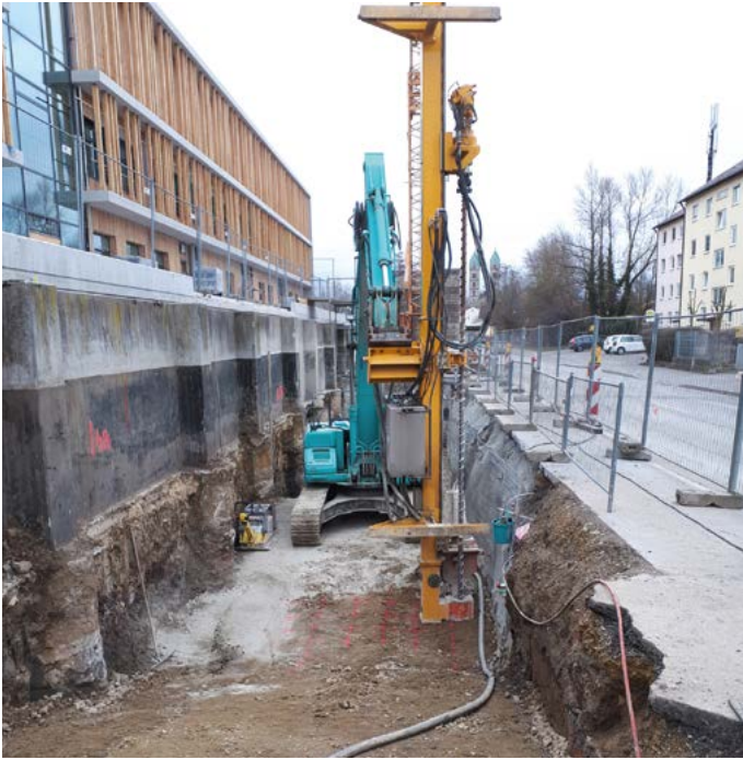
Abb. 15: Bodenverbesserung für das Zugangsbauwerk. Einblick in das Bestandstragsystem der Hochwasserschutzwand: Bohrpfähle und Schwarzabdichtung für die einseitige Böschung.
