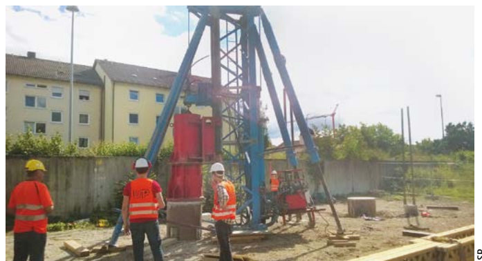
Abb. 5: dynamischer Pfahlversuch
