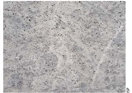
Abb. 12: Detailansicht der Infraleichtbeton-Oberfläche
