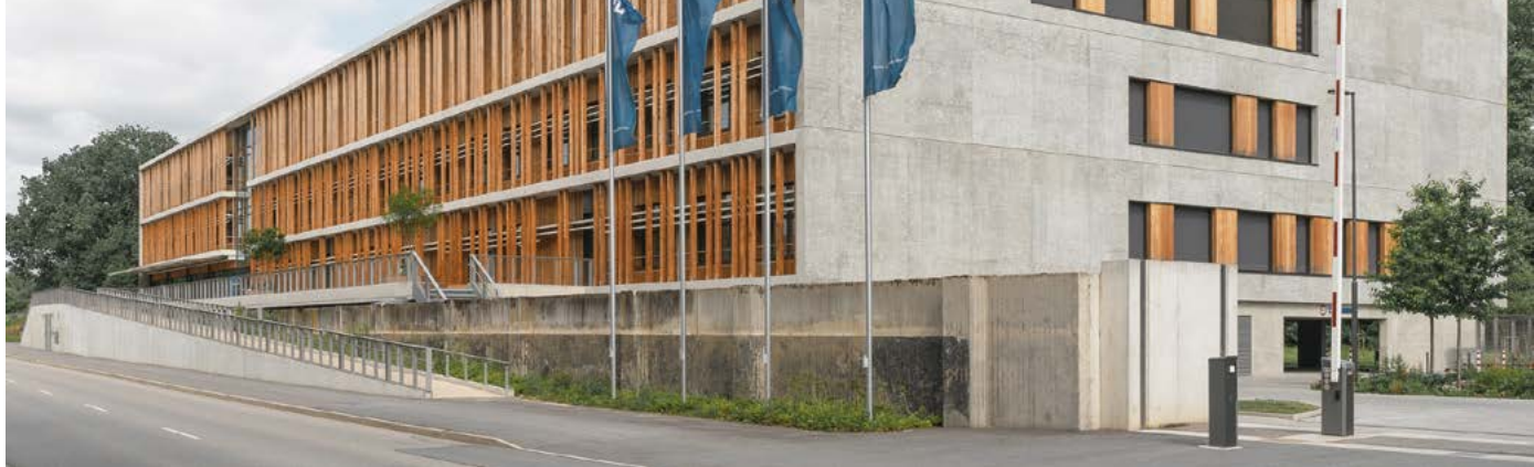
Abb. 1: Das Hörsaal- und Forschungsgebäude für Nachhaltige Chemie der TU München in Straubing. Im Vordergrund sind das Zugangsbauwerk und die Hochwasserschutzwand (Bestand) zu sehen.
