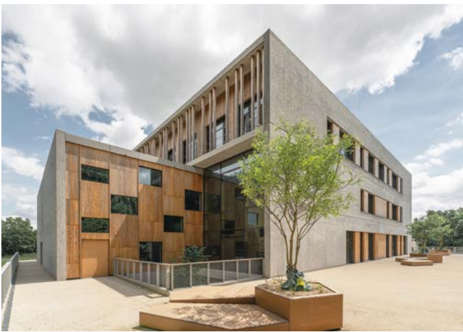
Abb. 9: die Außenansicht des Audimax, Holzfassade, Infralichtbeton
